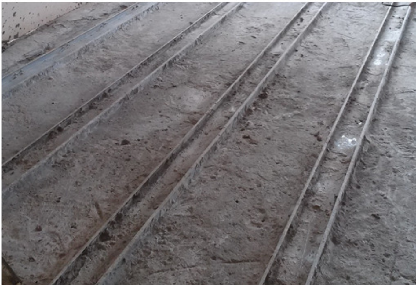
Фото 5. Тепло- и звукоизолирующий слой пенобетона.
