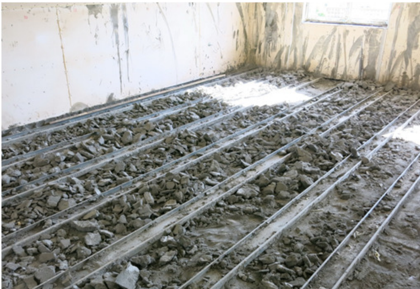
Фото 1. Уборка излишков тепло- и звукоизолирующего слоя пенобетона.
