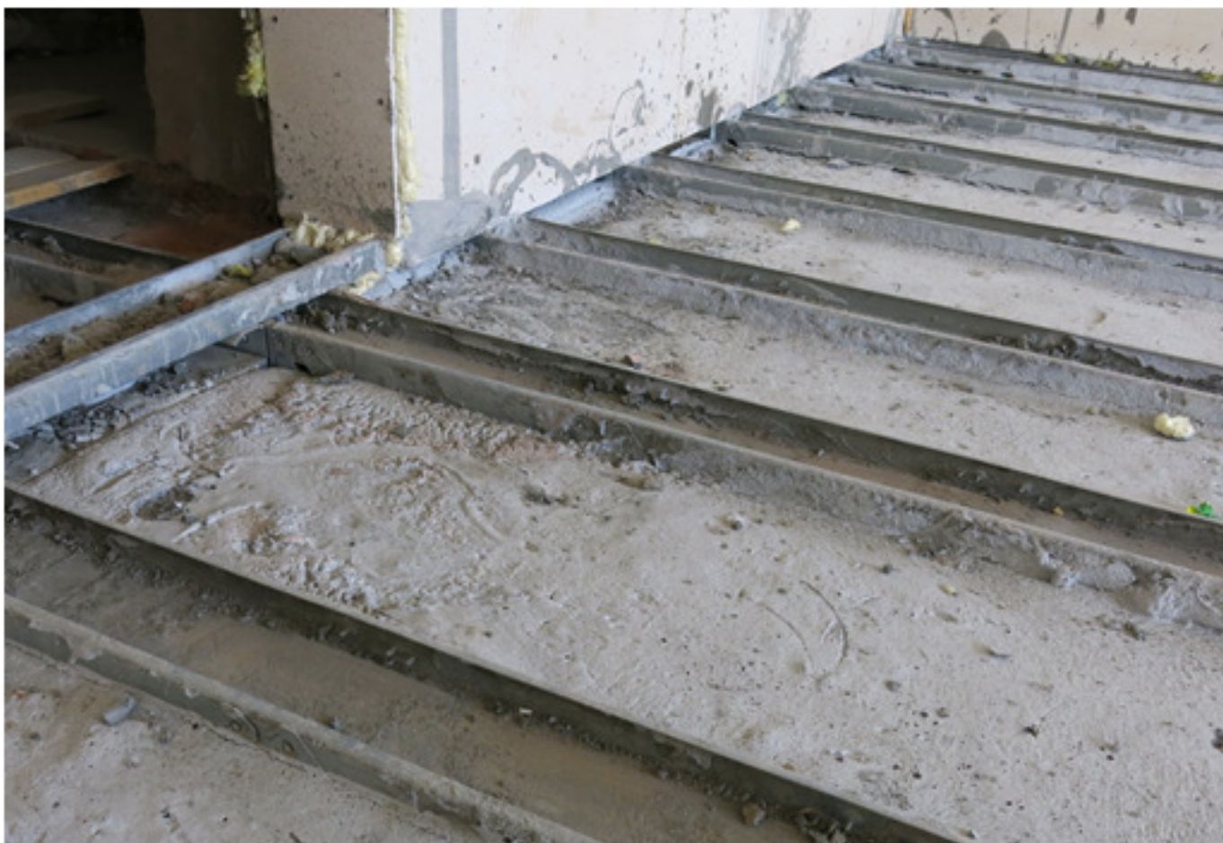
Фото 4. Тепло- и звукоизолирующий слой пенобетона.
