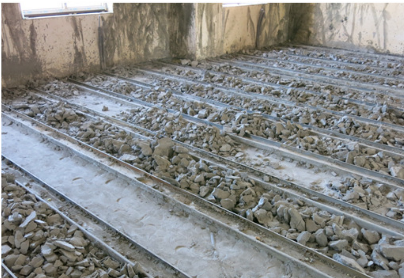
Фото 2. Уборка излишков тепло- и звукоизолирующего слоя пенобетона.
