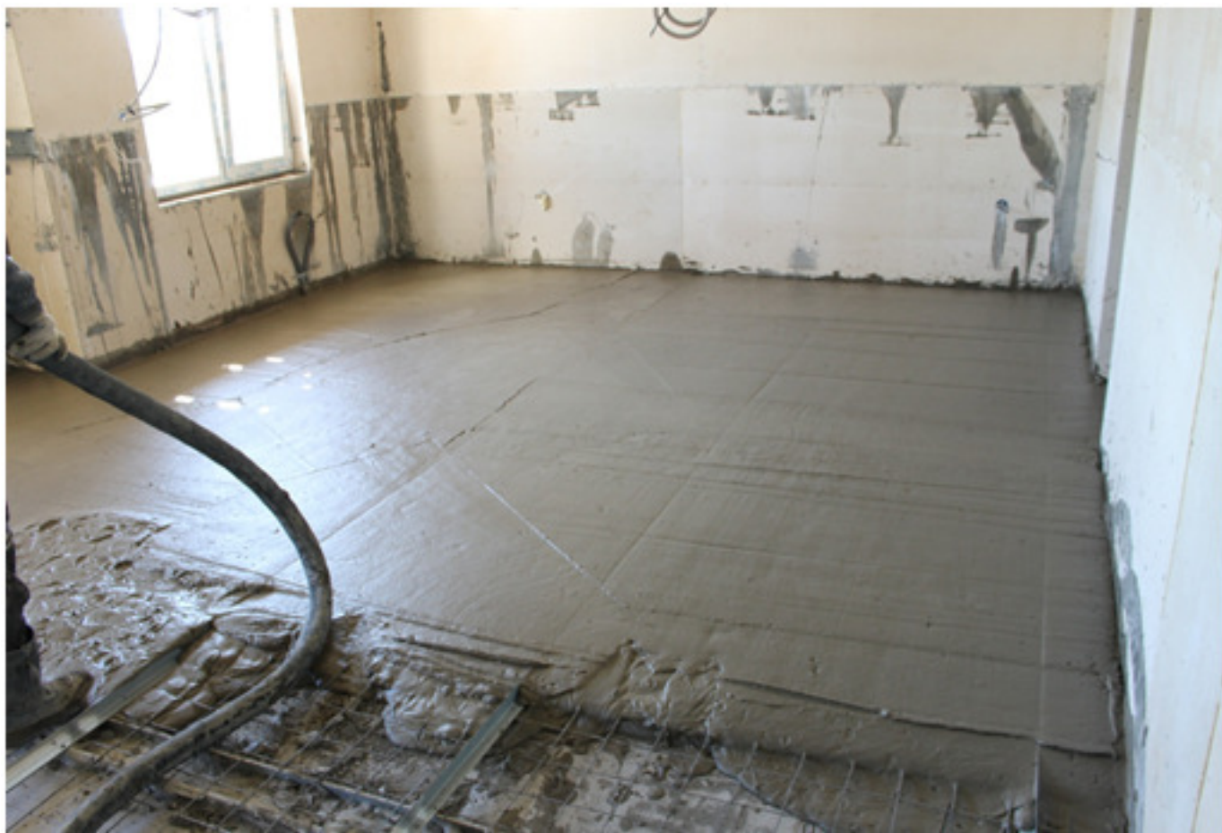
Фото 10. Укладка верхнего слоя пенобетона плотностью 1000 кг/м 3 .
