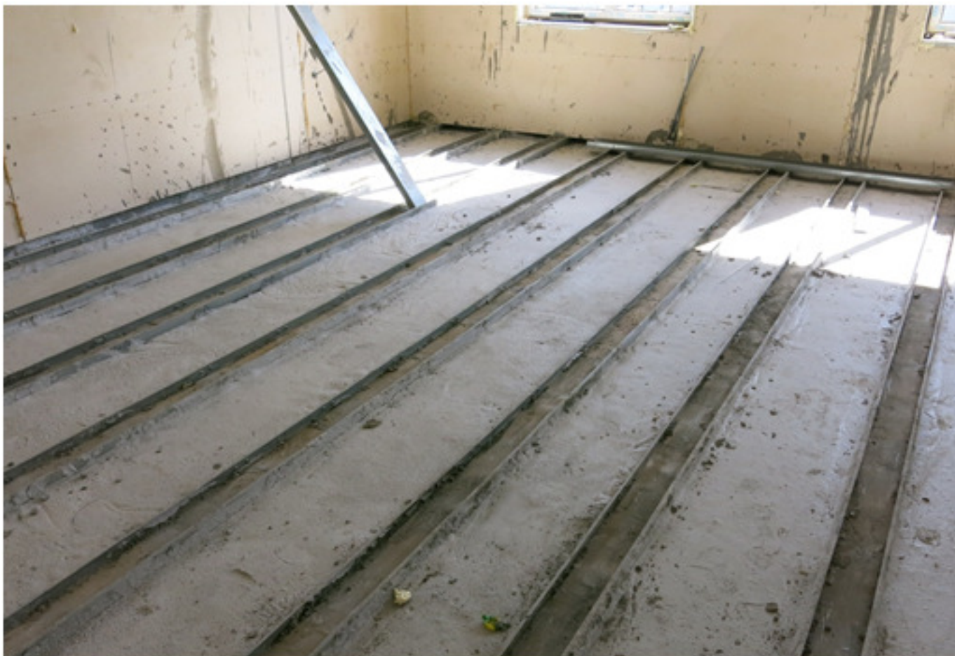
Фото 3. Тепло- и звукоизолирующий слой пенобетона.
