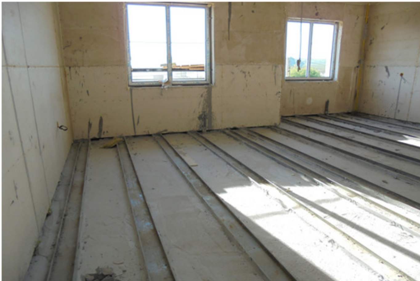
Фото 9. Тепло- и звукоизолирующий слой пенобетона.
