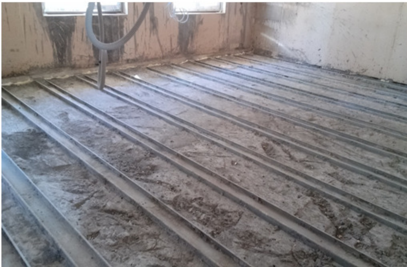
Фото 7. Тепло- и звукоизолирующий слой пенобетона.
