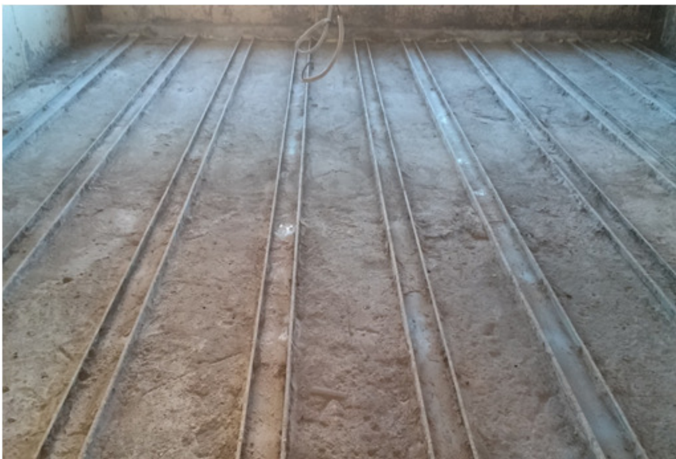
Фото 8. Тепло- и звукоизолирующий слой пенобетона.
