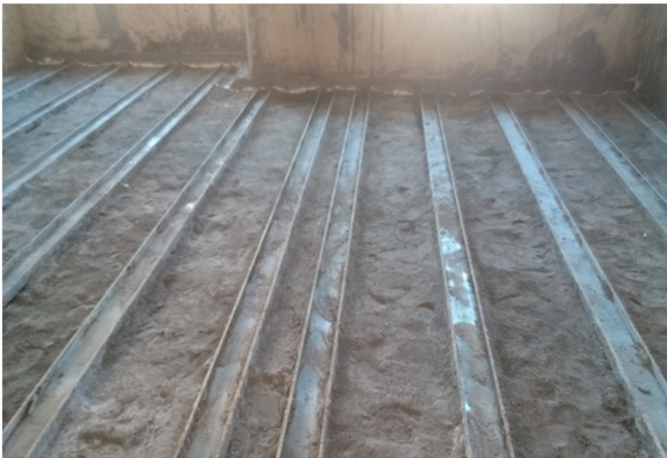
Фото 6. Тепло- и звукоизолирующий слой пенобетона.
